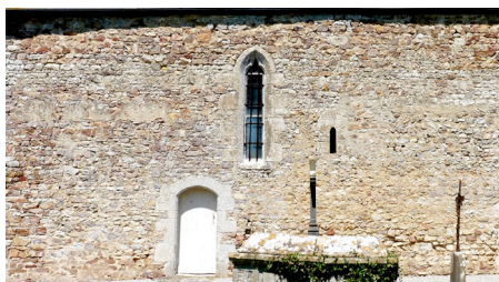
Crosville-sur-Douve, église Saint-Gervais-et-Saint-Protais, mur sud de la nef
