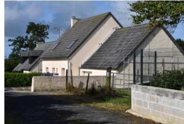
Habitat pavillonnaire - Acqueville
