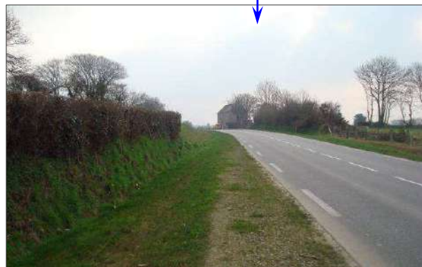
Exutoire dans le fossé de la RD 23
