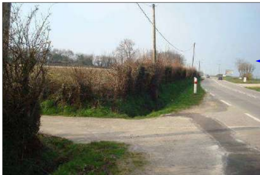
Exutoire dans le fossé de la RD 650
