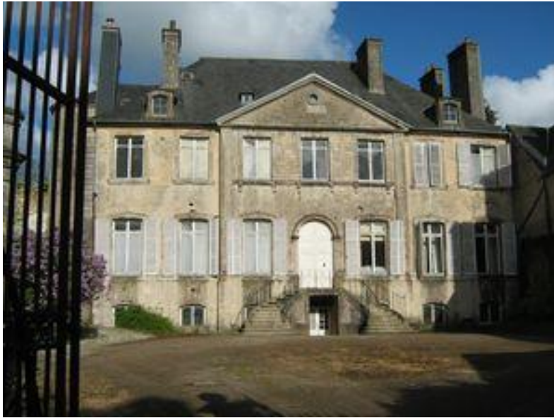
L'hôtel Pelée de Varennes, façade sur cour
