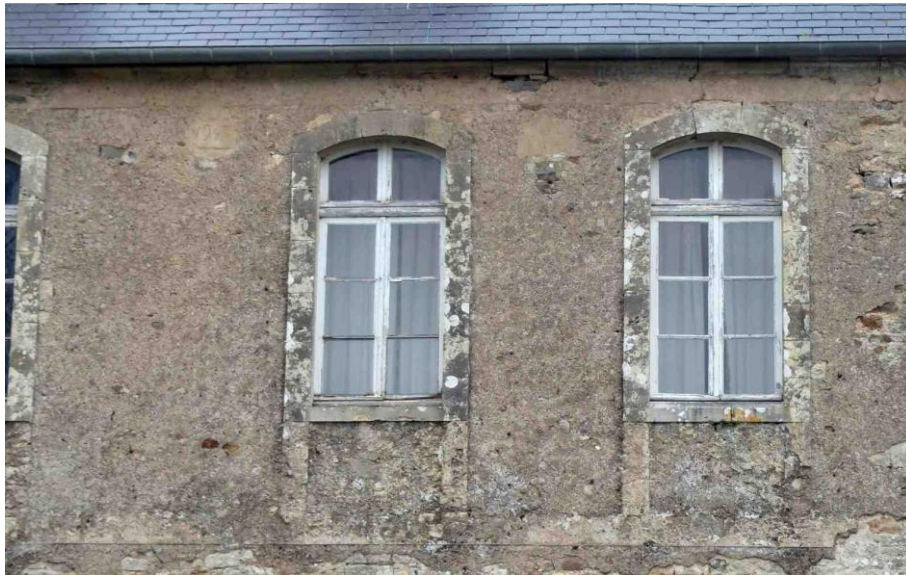
La Cour de Magneville, détail de l'enduit de la façade sud du petit logis
