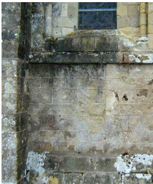
Teurtheville-Bocage, détail de l'enduit couvrant du mur de chevet
