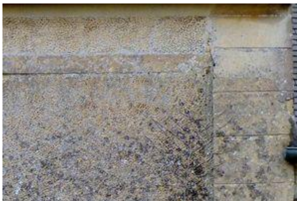
Fontenay-sur-Mer, maison du bourg. Les bandeaux horizontaux saillants et les chaînes d'angle, que l'on croirait taillés en pierre calcaire, sont en fait réalisés à l'enduit
