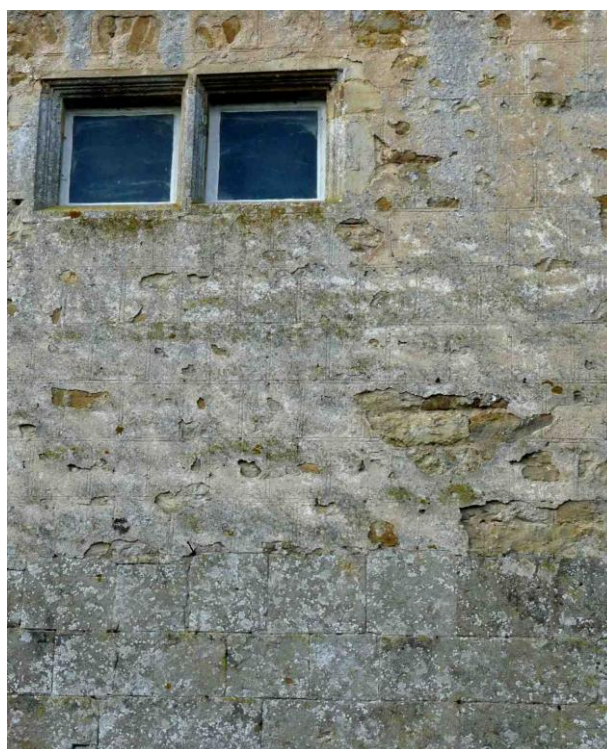
Joganville, Auberville, enduit incisé en faux appareil de la façade sud. Noter le raccord entre la surface ornée de « fausses pierres », en partie supérieure, et le solin en pierre de taille formant soubassement.
