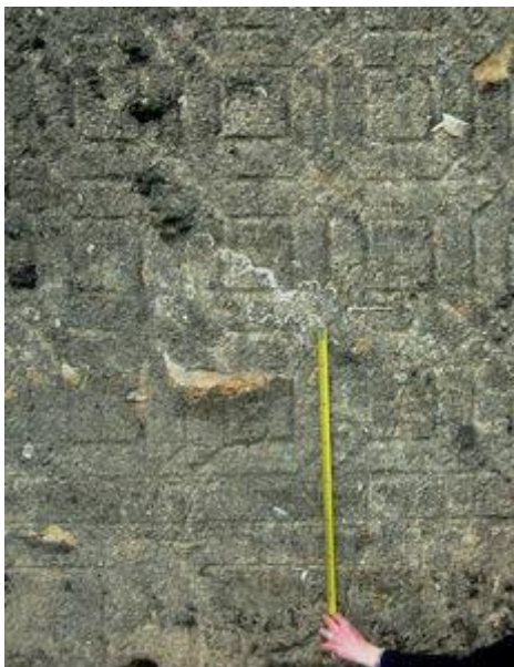
Brix, église Notre-Dame, mur nord du chœur, vers 1650
