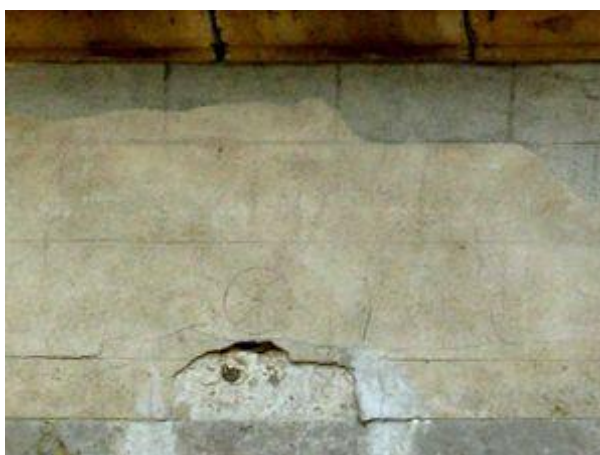
Valognes, hôtel Dursus, détail de l'enduit en faux appareil du XVIII e siècle. Noter le motif de rosace qui indique l'emplacement d'un trou de boulin destiné à fixer un échafaudage.
