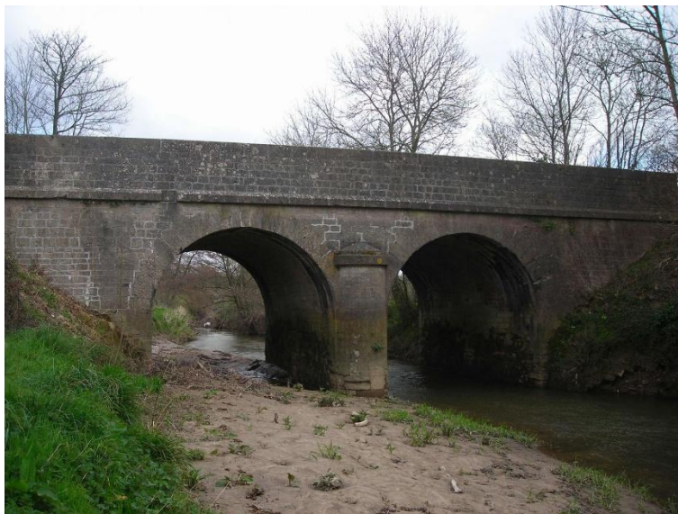
Pont-aux-Bouchers, côté amont
