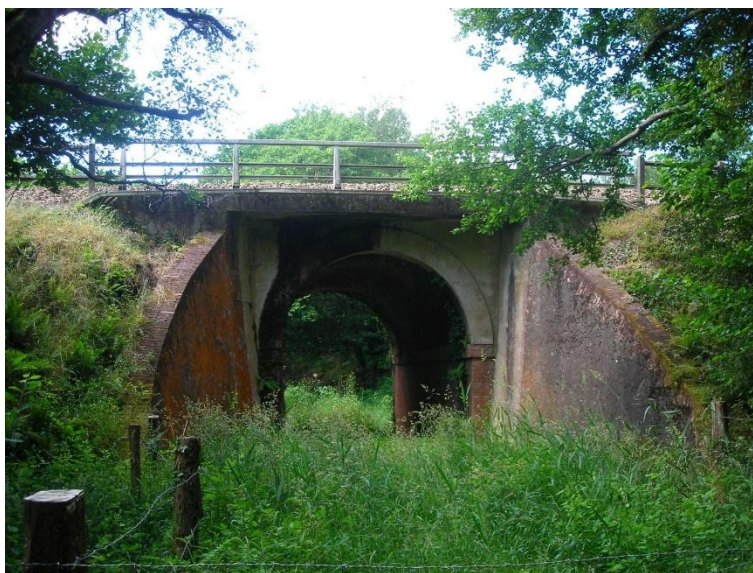
Pont-rail de Breuville
