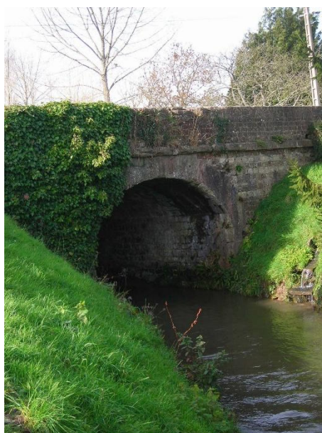
Pont en amont du pont d'Aisy
