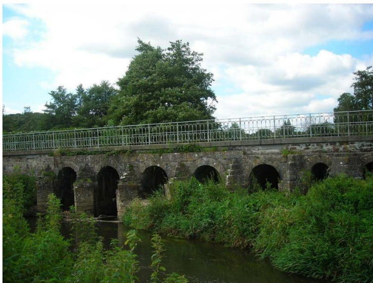
L'Etang-Bertrand, pont central de la chaussée, côté amont
