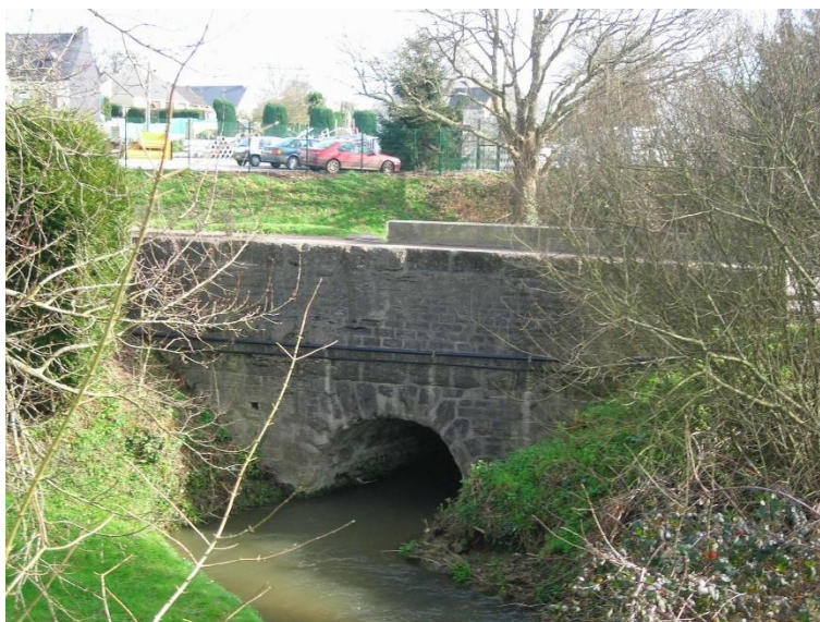
Pont sur la RD 902
