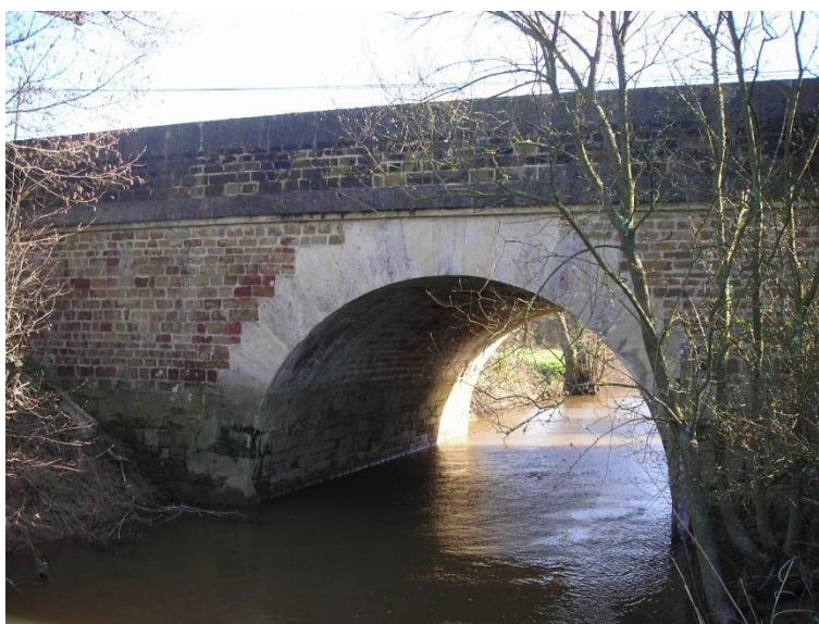
Pont du Vrétot côté amont
