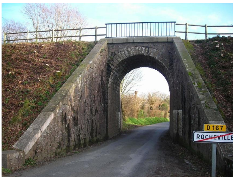
Pont-rail de Rocheville
