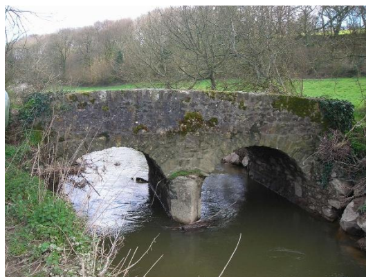
Pont de Malassis, côté amont
