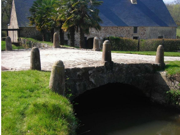
Ponceau du bief du moulin
