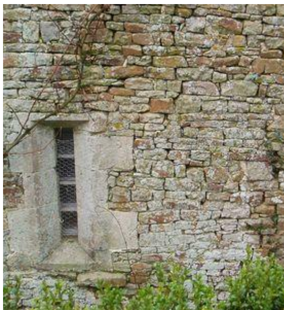
Ancien presbytère, détail de maçonneries médiévales
