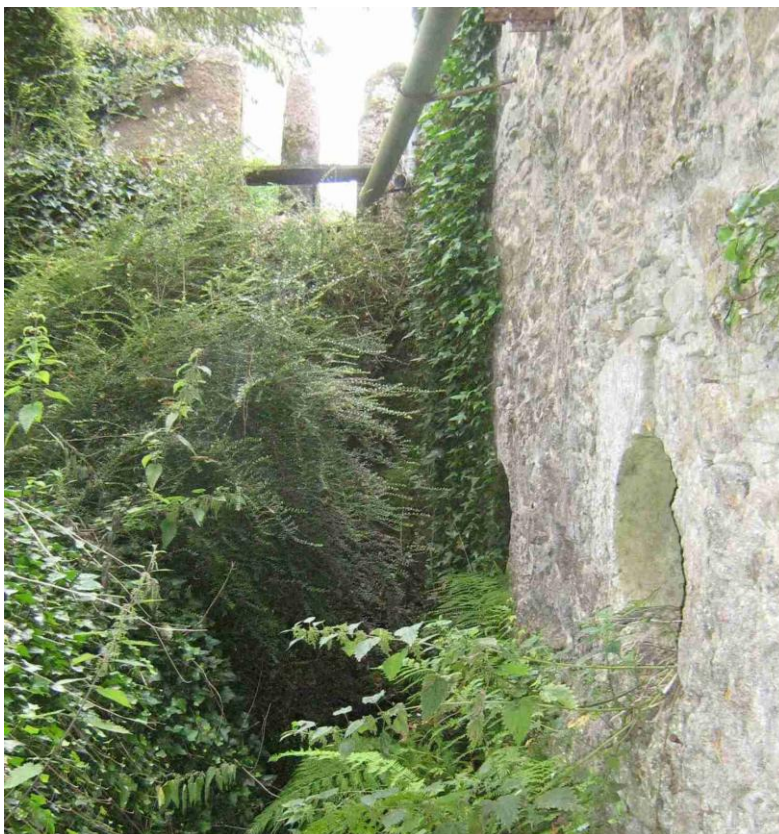
Mur pignon nord du moulin
