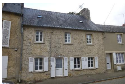
Etat actuel après transformation en logement
