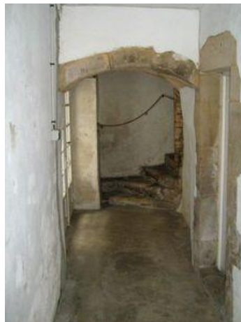
Couloir et entrée de la cage d'escalier en vis
