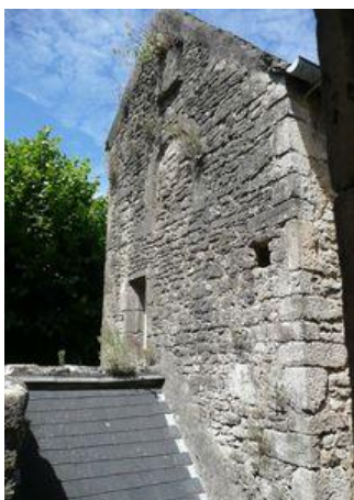
Tour quadrangulaire couverte en bâtière sur l'arrière de l'édifice
