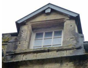
Détail d'une fenêtre de comble
