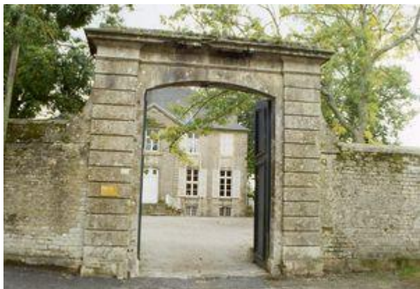
Portail charretier ouvrant sur le parc
