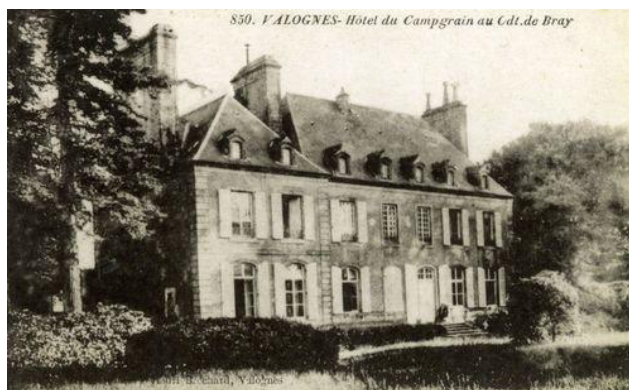
Façade postérieure, vers 1900
