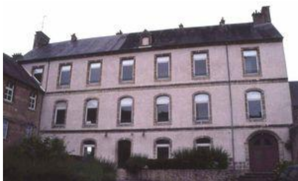
Corps de logis entre cour et jardin
