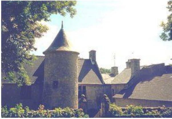
Façade sur cour
