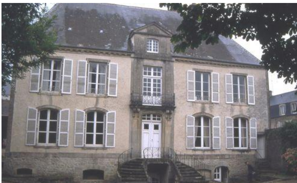
Hôtel dit de Carmesnil, façade antérieure
