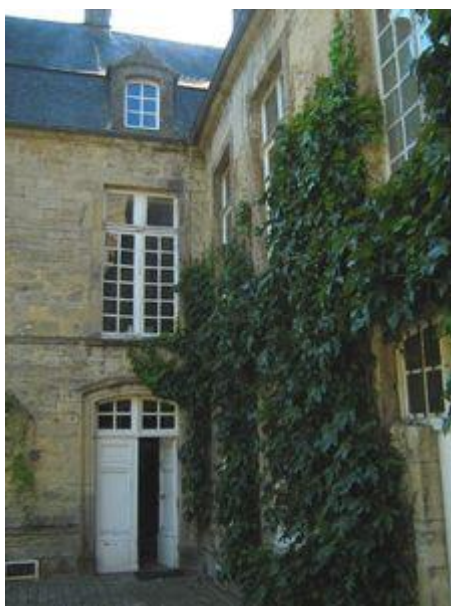
Jonction des deux ailes du côté de la cour
