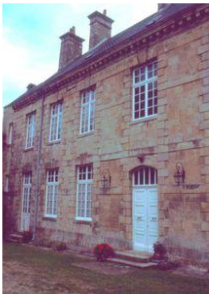
1. Façade sur cour
