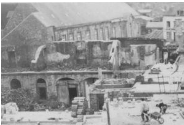
La reconstruction de l'hôtel d'Anneville après la seconde guerre mondiale. On aperçoit les écuries subsistantes en rez-de-chaussée de l'aile en retour
