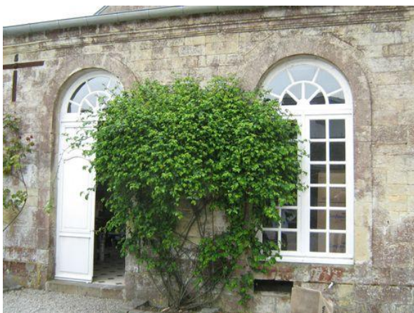
Partie ancienne subsistante de l'aile des communs (1692)
