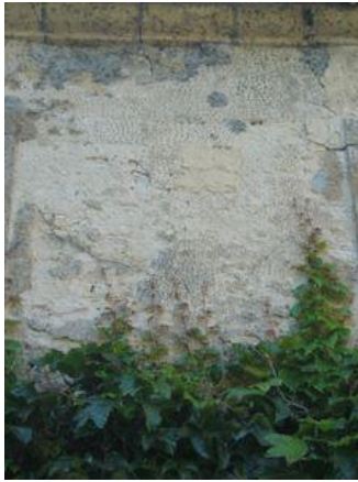
Vestiges d'enduit au clou du XVIII e siècle sur la façade postérieure
