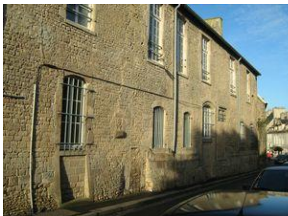
Aile sur rue intégrant des vestiges de la construction de la fin du Moyen-âge
