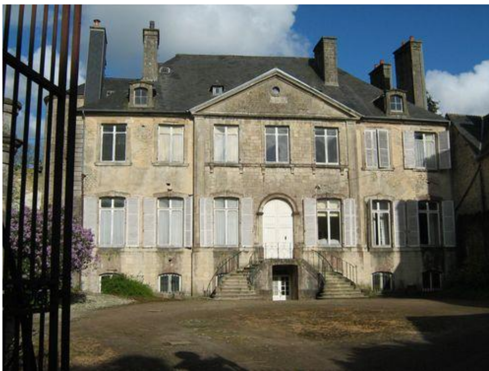
Façade sur cour
