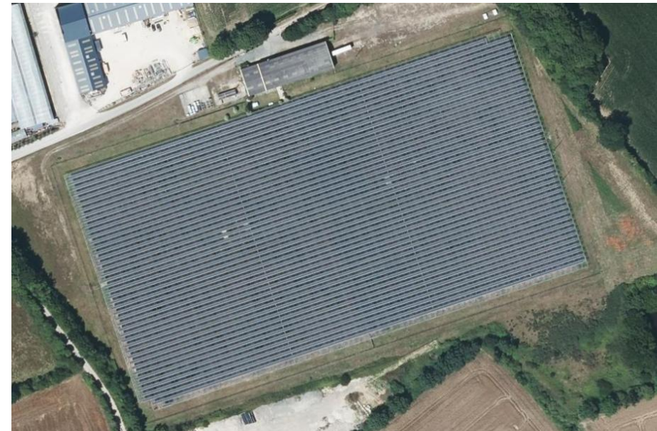
Parc photovoltaïque (Benoîtville)
