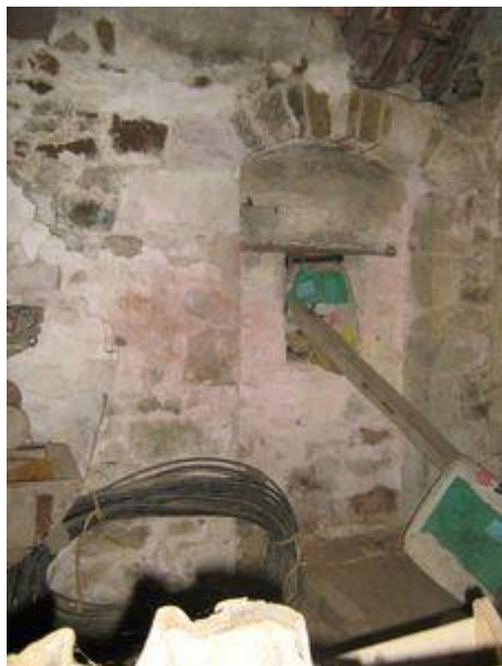
Porte du XVe siècle à l'étage du logis. La rainure oblique située à gauche correspond à l'ancrage du manteau de cheminée de l'édifice primitif.
