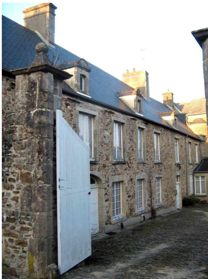
Façade sur cour de l'actuel presbytère
