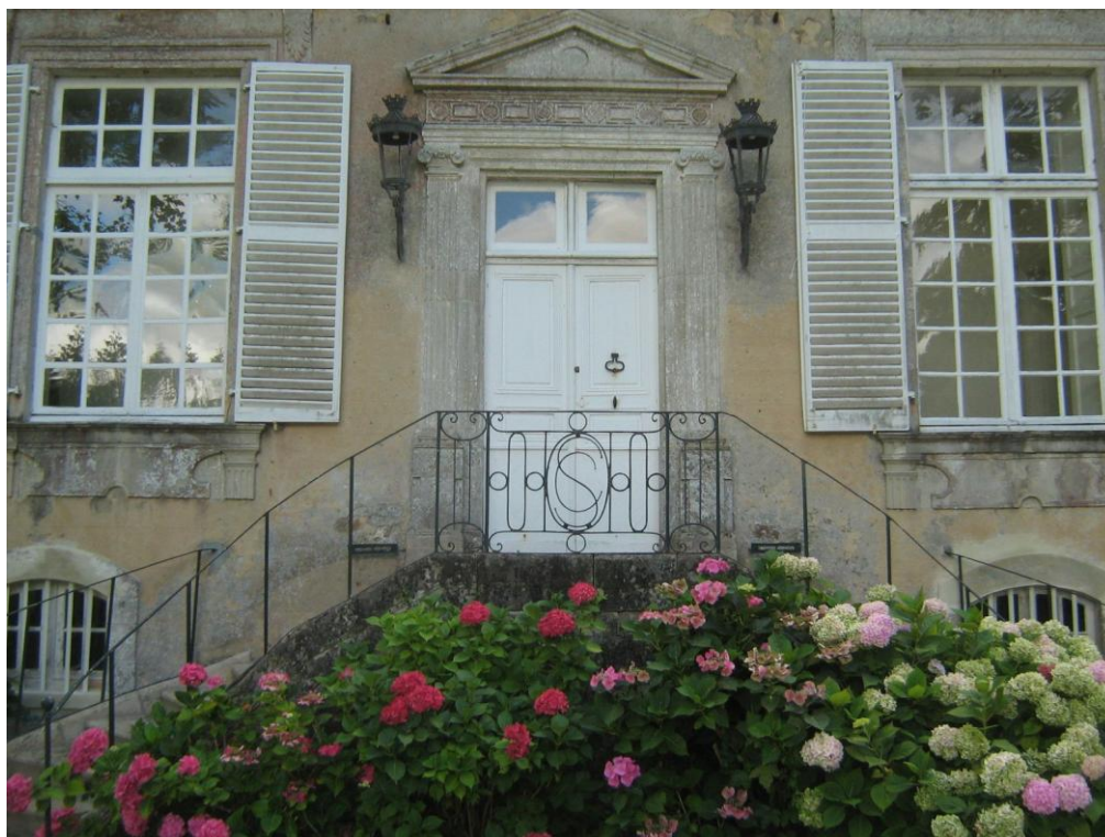
Façade nord, détail de porte Renaissance
