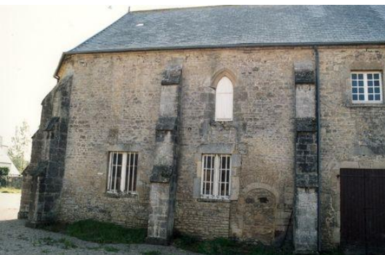
Flanc nord de la chapelle avant restauration
