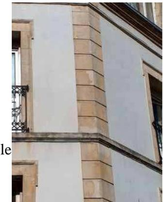
**Chambranle** : Ornement saillant qui encadre sur trois côtés les ouvertures des portes, des fenêtres et des cheminées afin de dissimuler la jonction entre le mur et l'ébrasement. Le chambranle est généralement fait de bois, de pierre ou de marbre et se compose de deux montants verticaux et d'une traverse horizontale. Le chambranle peut prendre la forme d'une simple baguette plate ou d'une moulure profilée.
