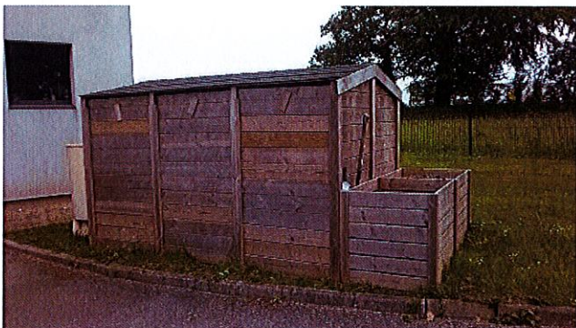
Pavillon de compostage – Cuisine centrale Les Pieux
