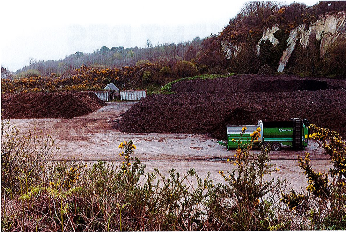
Centre de compostage de Tourlaville
