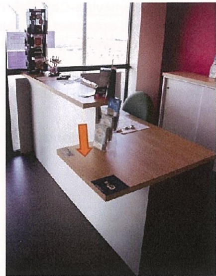
La banque d'accueil est abaissée pour l'accueil handicap.
