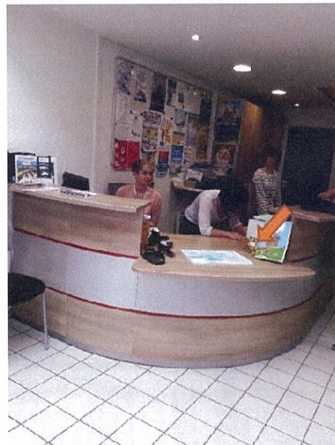
La banque d'accueil est abaissée pour l'accueil handicap.
