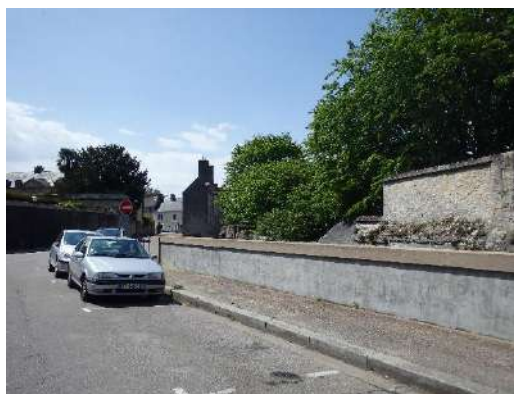
Photographie des travaux en direction de l'ouest (hôtel de Beaumont) et vue actuelle du parapet en béton créé à cette date pour recouvrir le Merderet.
